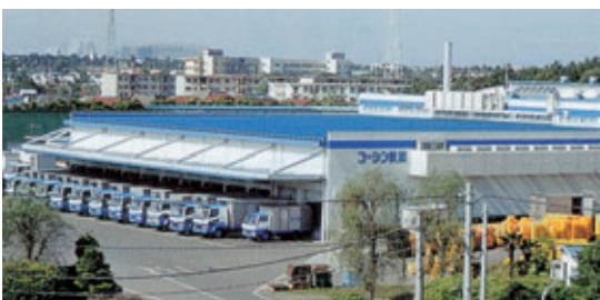
千葉工場全景▶
