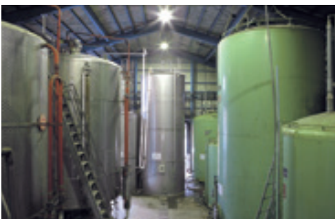
▲近代的タンクではモーターが常時作動している
