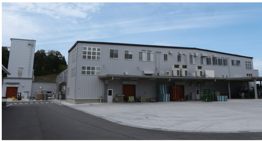
▲白河工場（新工場）外観
